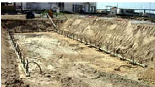
Le principe consiste à mettre en place à la périphérie du terrassement un réseau de pompes qui vont créer une dépression locale dans la nappe phréatique. Le niveau de l'eau descend localement. Un dimensionnement permet de faire descendre le niveau sous le niveau fini du terrassement. Les fouilles peuvent ainsi être réalisées au sec. Cette technique nécessite d'avoir de la place autour de la zone à terrasser pour installer le réseau de pompe et d'évacuation d'eau.
