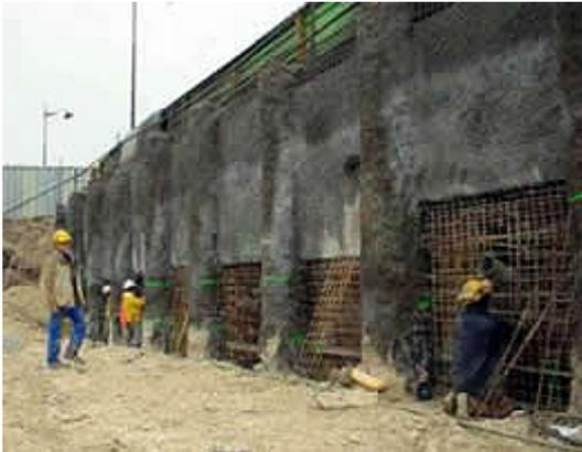
Le principe technique est le même que la paroi berlinoise. Mais la paroi est réalisée en béton armé. C'est la paroi périphérique de l'ouvrage. Les profiles métalliques sont remplacés par des poteaux en béton armé avec des aciers en attentes repliés le long. Ces poteaux sont enfoncés dans le sol ou réalisées par forage.
