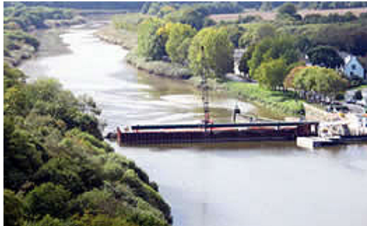
Batardeau en rivière
