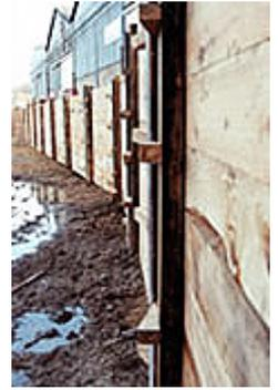
L'ouvrage peut ainsi être réalisé sans craindre l'éboulement des terres. Plus coûteuse que la fouille en pleine masse, cette technique a l'avantage d'utiliser moins d'espace. Elle est donc intéressante pour les travaux réalisés en centre urbain où la surface du chantier correspond souvent à la surface de l'ouvrage à réaliser.
