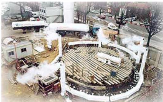
Le principe consiste à congeler le sol et l'eau localement le temps des travaux.
