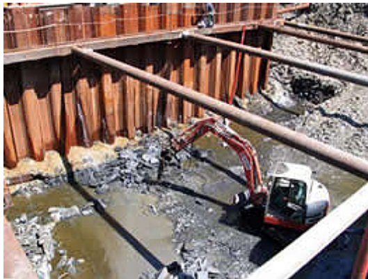
Terrassement dans le batardeau mis au sec par pompage
