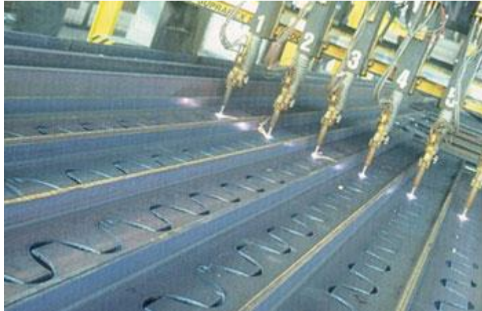
Figure 10 découpage de profilés pour fabrication de poutres ajourées
